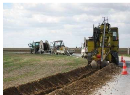
Figure 52: Exemple de travaux d'enfouissement du réseau de raccordement
