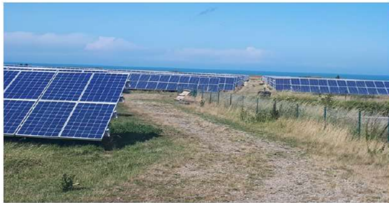
Figure 49 : Exemple de piste légère (Source : Oxynergie)
