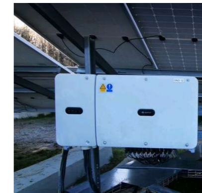
Figure 43 : Exemple d'onduleur décentralisé (Source : Oxynergie)
